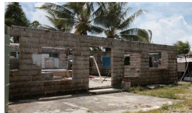
写真 4 サイクロン「ウラ」で屋根が飛ばされた家
