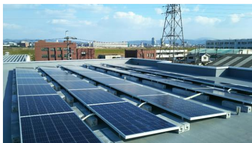
作業所グループホーム屋上
