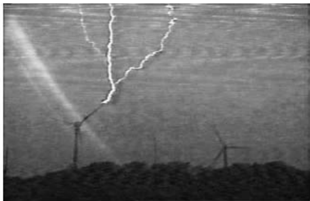
ブレード先端からの上方放電をとらえた珍しい写真：NEDO 調査より
