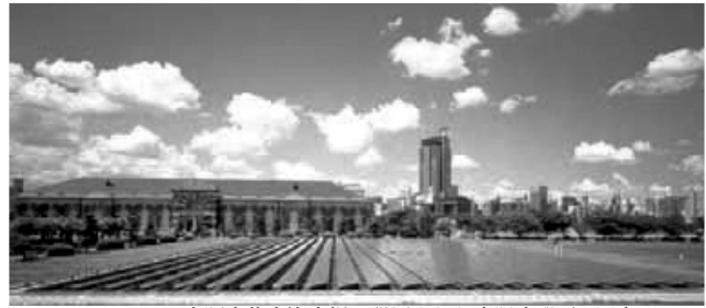
大阪市柴島浄水場に設置された太陽光発電 (写真 NEDO)
