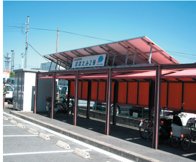
駐輪場に設置された地域共同発電所 (滋賀県野洲市, 2004年9月, 撮影: 和田武)
