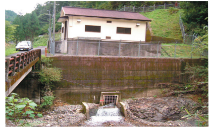
発電所全景と放水口
