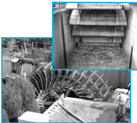
図3 都留市家中川市民発電所（用水路に建設された開放型下掛け式水車（20kW））（ひまわりニューエネルギーのHPより）
