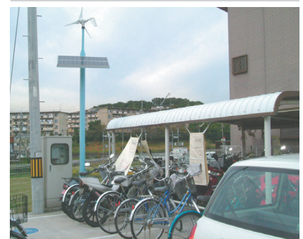
図3 小型風力・太陽光ハイブリッド設備
