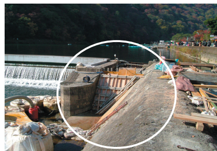
図4 嵐山渡月橋市民小水力発電所建設現場（サイフォン式プロペラ水車が設置される）
