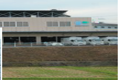
図2 建物横幅一杯に設置された太陽光発電所
