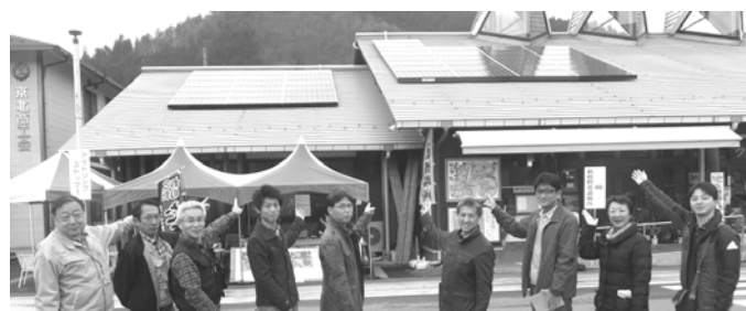
ウッディー京北に設置された京都市市民協働発電 (写真提供：市民エネルギー京都)
