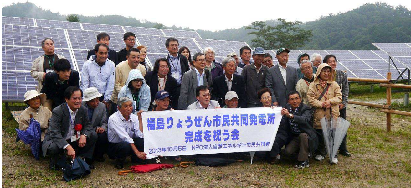
福島県農民連と協力して 2013 年に完成した「福島りょうぜん市民共同発電所(50kW)」
