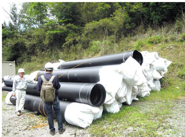
写真①「埋設する導水管」
