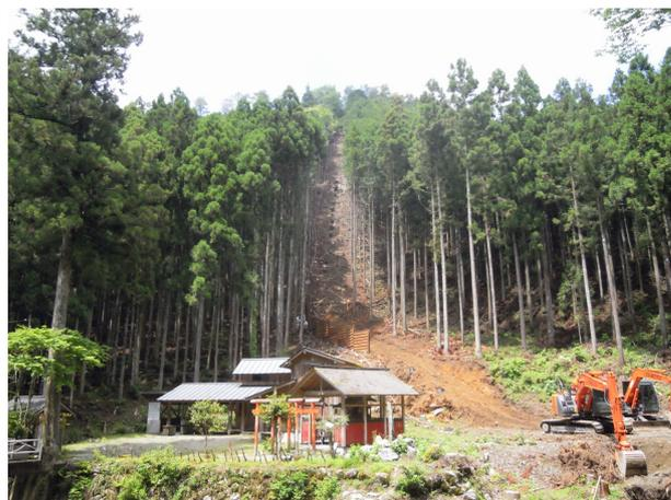
写真②「発電所予定地と圧力鉄管を敷く落差100mの崖」
