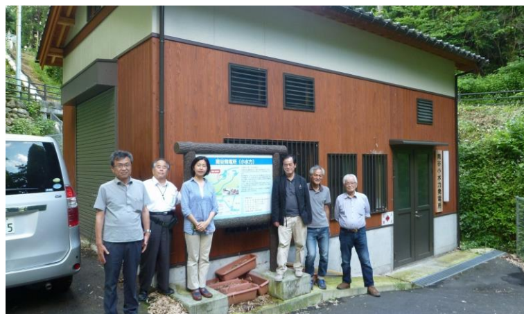
南谷小水力発電所の見学
