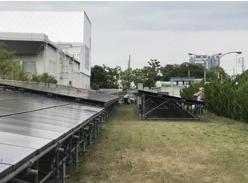
パネルの下の草は根っこから引き抜きました
