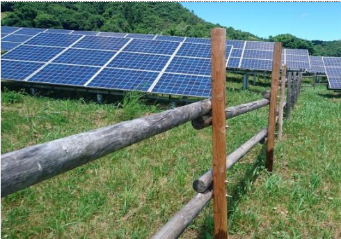
新しく打ち直した杭
