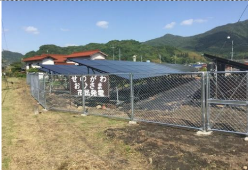
せのがわ工事完了
