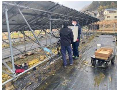
パワコン入替作業の様子
