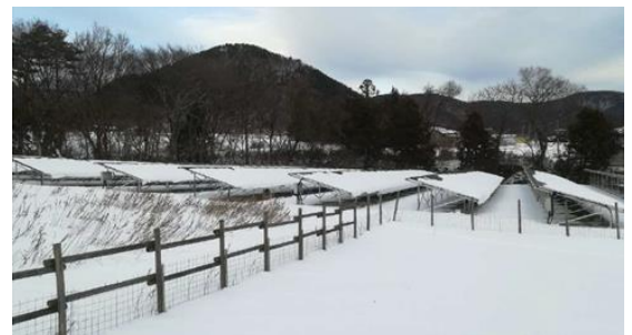
1月6日の定期点検時のあたままちの状況
