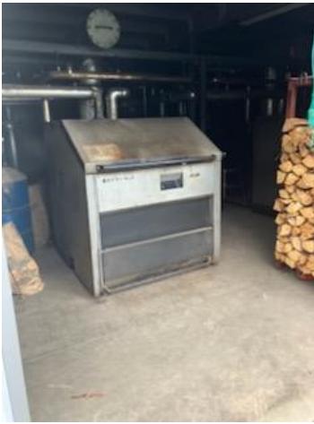
＜写真4＞薪ボイラー（約1400度の高温）
